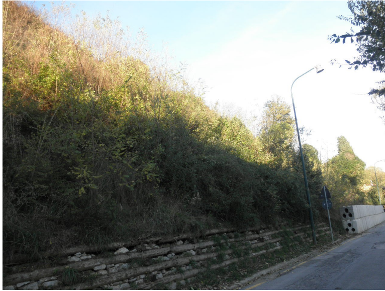
Foto n. 1: intervento di stabilizzazione dell'anno 2009
